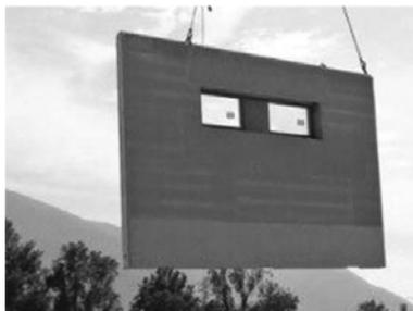
La structure d'un immeuble à ossature en bois est constituée de montants et de traverses sur lesquels seront fixés des panneaux. Lorsque la structure de l'immeuble est terminée, on passe à l'assemblage des panneaux préfabriqués ; ceux-ci sont levés avec une grue à tour qui permet de lever les charges au moyen d'un système de palan. On étudie une étude mécanique du levage d'un panneau de masse  $M = 650 \text{ kg}$ .
